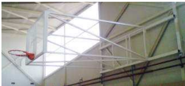
Cistella de 2,5 m entre encavallades mitjançant estructura metàl·lica soldada i cable tirant de subjecció.
