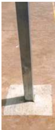
Detalle del hormigonado de anclaje para canasta fija. El anclaje se suministra con la canasta.
